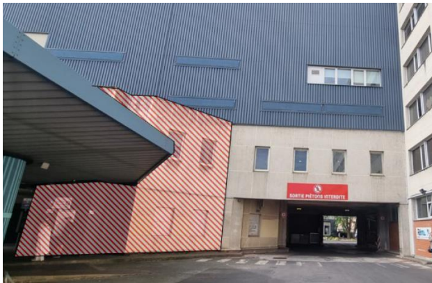
Photo extraite du dossier d'enquête montrant la partie hachurée rouge du volume appartenant au Département du Loiret, aujourd'hui désaffecté, qu'il est prévu de démolir afin d'améliorer la fonctionnalité et la capacité de la gare.
