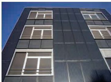
Réhabilitation thermique d'un immeuble collectif de 7 logements de 1938 (Agglomération de Bourges) Opération certifiée « Patrimoine, Habitat et Environnement » Consommation passée de 495 à 209 kw/m 2 /an Emission de Gaz à Effets de serre passée de 116 Kg à 12 Kg de CO 2 /m 2 /an
